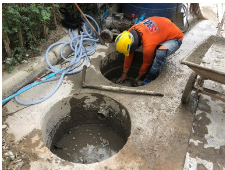
ภาพที่ 4-21 จุดลอกตะกอนที่บ่อพักน้ำทั้งก่อนระบายออกสู่ภายนอกโครงการ
