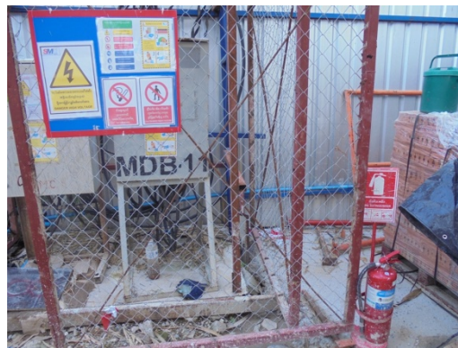
ภาพที่ 4-16 ถึงเคมีดับเพลิงตั้งไว้บริเวณที่เสี่ยงต่อการเกิดเพลิงไหม้พร้อมคู่มือการใช้งาน
